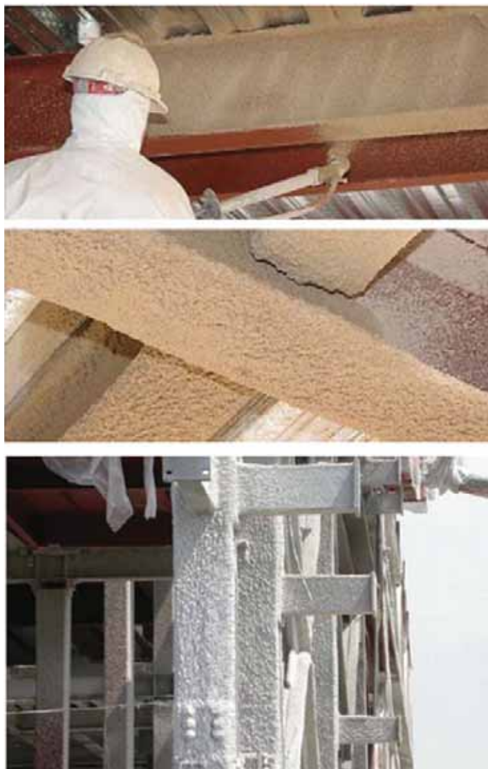
ภาพที่ ๔๕ การป้องกันโครงสร้างเหล็กโดยการพ่นด้วยวัสดุทนไฟ
