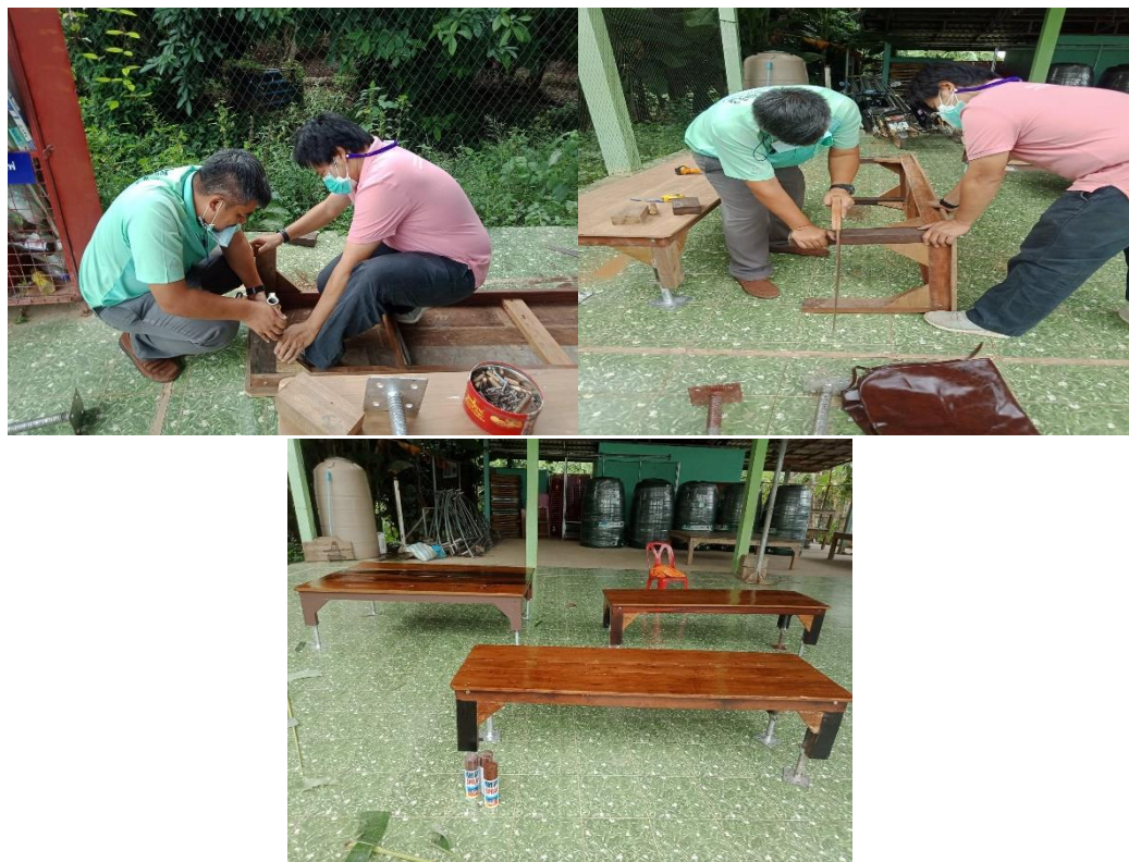
ภาพที่ 2 การดำเนินการและภายหลังที่ดำเนินการแล้วเสร็จ
