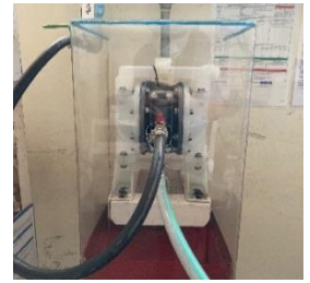
ภาพที่ 8 อุปกรณ์ครอบปั๊ม หลังการแก้ไข
